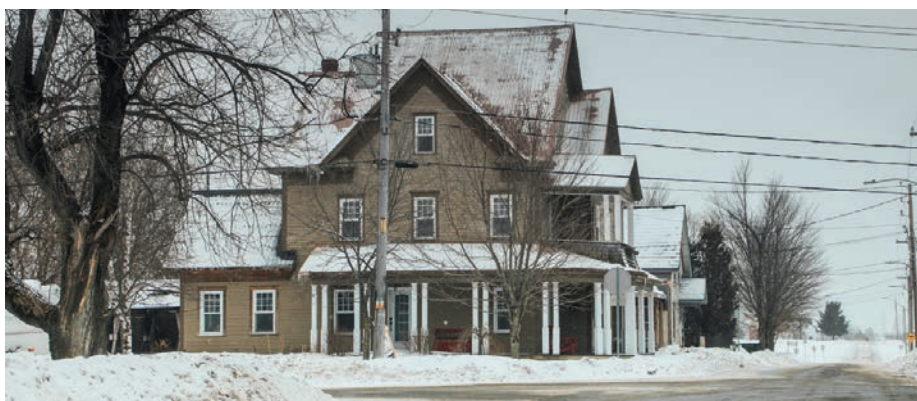
7. Saint-Ignace-de-Stanbridge Demeure monumentale au carrefour de ce village de croisée.
